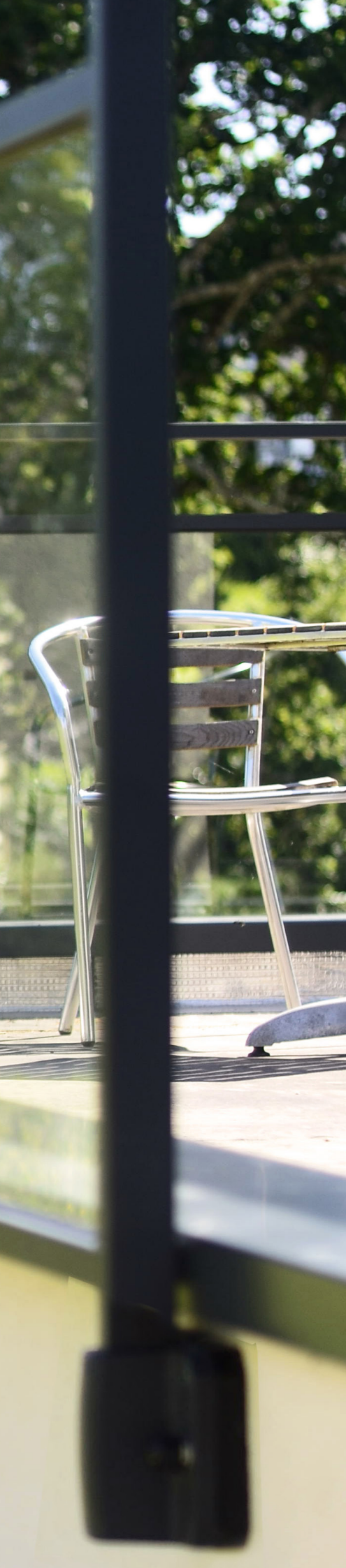
MEL Garde-corps vitrage clair. Pose en nez de dalle. Main courante KAY. Coloris Noir Sablé - RAL 2100
